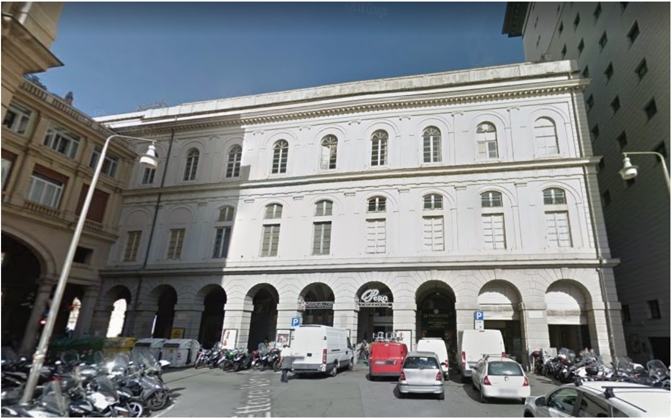
il prospetto posteriore dopo i lavori dei primi del '900
