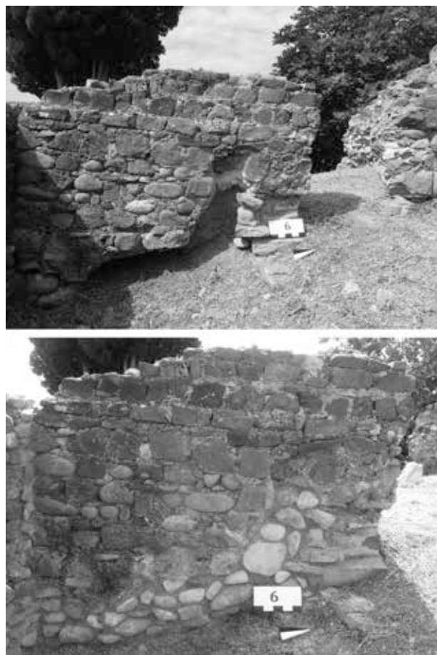
Fig. 1. Sanremo (IM). Villa di Bussana. Muratura sud-occidentale del vano 8 prima e dopo l'intervento di restauro.
