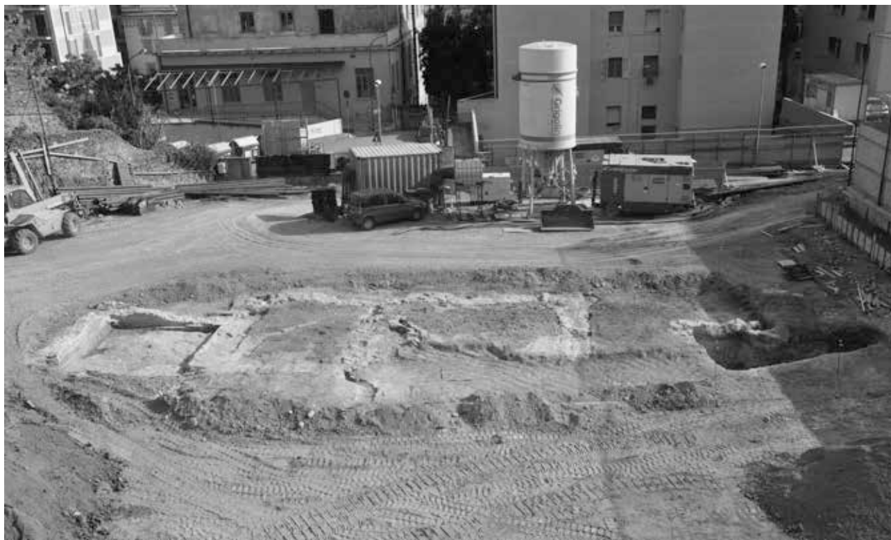
Fig. 2. Varazze. Via Don Paseri. L'edificio e la cava di estrazione in fossa, da Nord.
