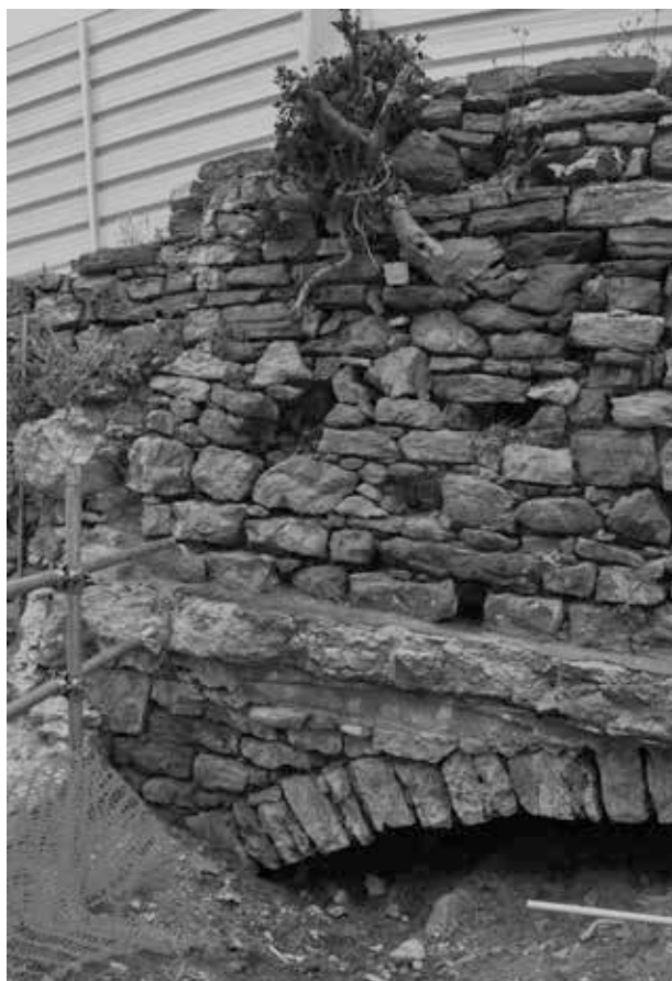
Fig. 2. Porto Venere. Cantiere della Locanda San Pietro. Corpo 3, muratura ad arco stratigraficamente legata ad altra in grandi blocchi, in progetto di scavo e di vincolo.
