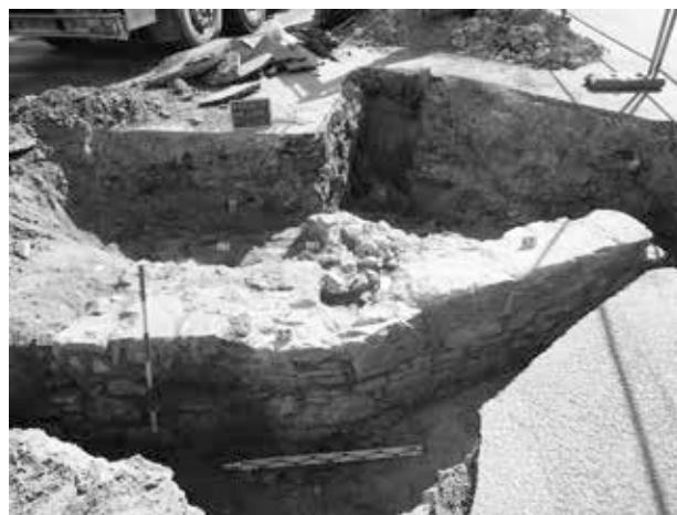
Fig. 2. Alassio (SV). Viale Hambury incrocio Via Gibb. Le strutture relative al bastione nord (US 39, US 49).
