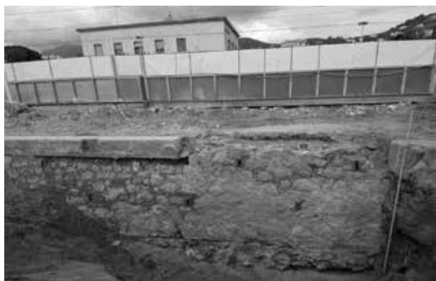
Fig. 2. Pietra Ligure. Stazione ferroviaria. Il muraglione di contenimento dello spazio ferroviario rinvenuto nella porzione meridionale del cantiere.
