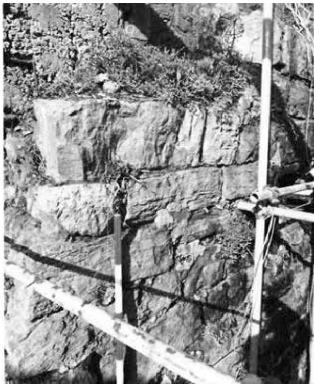
Fig. 1. Porto Venere. Cantiere della Locanda San Pietro. Corpo 1, opera muraria USM 540 a grandi blocchi.
