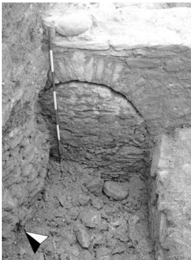
Fig. 3. Carasco (GE). Chiesa di Sant'Eufemiano in Graveglia. Il prospetto occidentale del muro US 14 dotato di ampio arco leggermente ribassato e la successiva tamponatura US 69 (periodo II).
