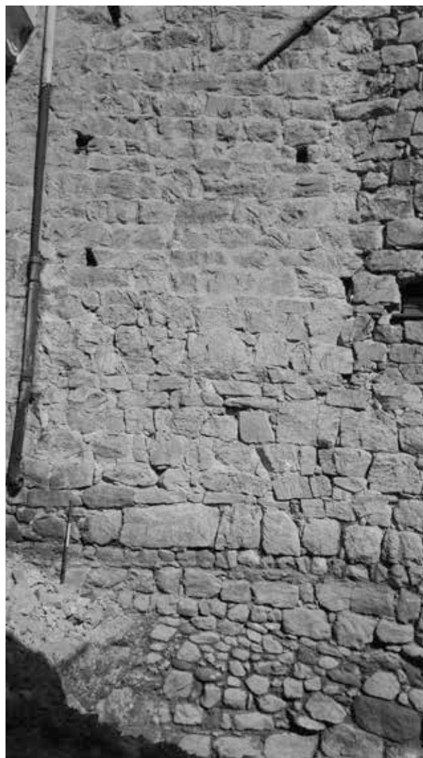
Fig. 1. Noli. Rio Noli. Prospetto della cinta all'altezza del saggio I.
