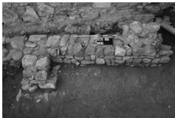
Fig. 4. Strutture murarie in area 100 (periodo III).
