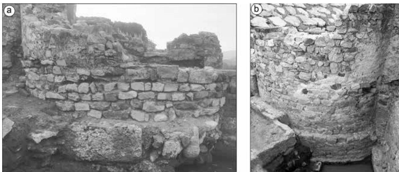
Fig. 16. Vedute dei prospetti delle due absidi minori in petit appareil degradato con fondazione in blocchi di riutilizzo dal complesso termale (a. abside settentrionale; b. abside meridionale).
