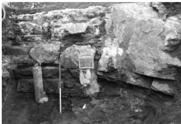
Fig. 2. Savona. Area del Priamar. US 108, particolare del prospetto a Sud a fine lavori.
