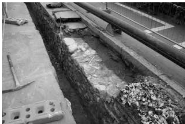
Fig. 5. Alassio. Via Milano. Particolare da Nord della muratura USM 1 nell'ampliamento B (rilievo G. Marello; elaborazione grafica R. Managlia).
