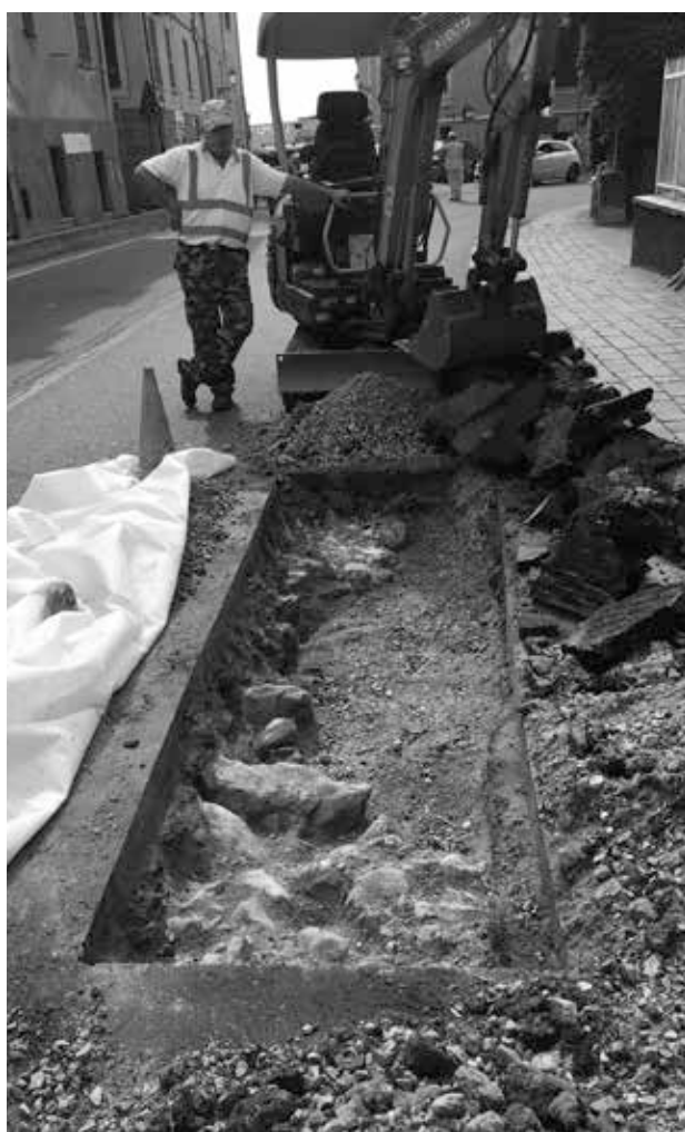
Fig. 2. Celle Ligure. Via Poggi. Particolare del sondaggio F.
