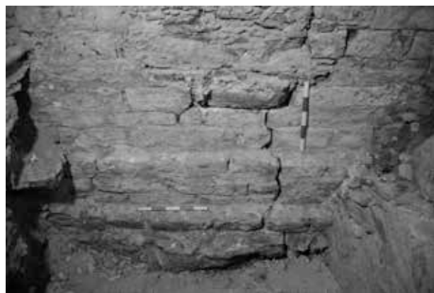
Fig. 2. Campomorone. San Siro di Langasco. Dettaglio della muratura medievale posta in luce nell'intervento n. 4.
