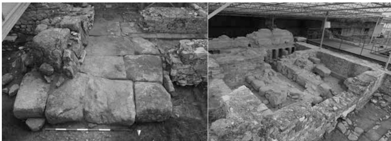
Fig. 2. Ventimiglia (IM). Terme. Strutture dei praefurnia oggi a vista (a sinistra il vano VII, a destra il vano VI).
