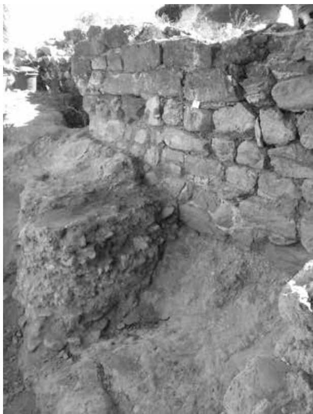
Fig. 1. Savona. Complesso del Priamar. Tratto del muro perimetrale orientale della fase altomedievale della cattedrale.
