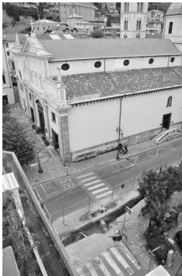
Fig. 1. Alassio. Via Aurelia. Panoramica del limite occidentale della braida orientale.
